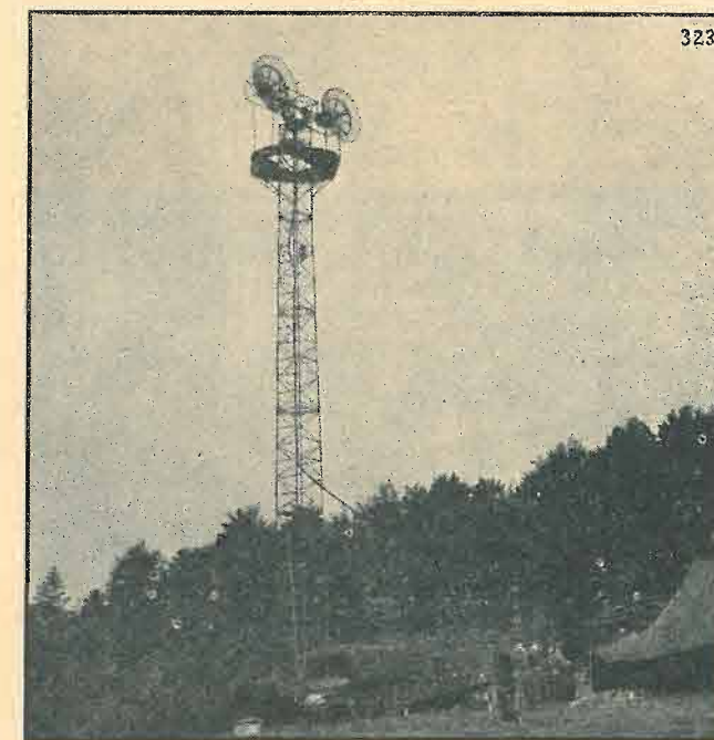
Fig. 4. - Antenne con riflettore parabolico mediante le quali si effettuano le trasmissioni su onde metriche che si utilizzano anche per la modulazione di frequenza.
